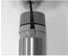
Kuva (24) Kantoranaru asentaminen
